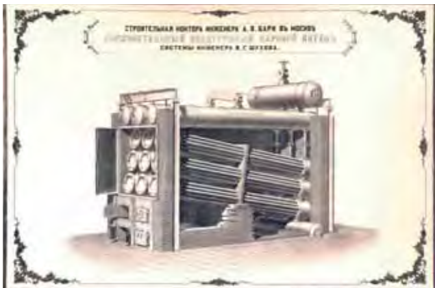
▲ Изображение парового котла В.Г. Шухова
