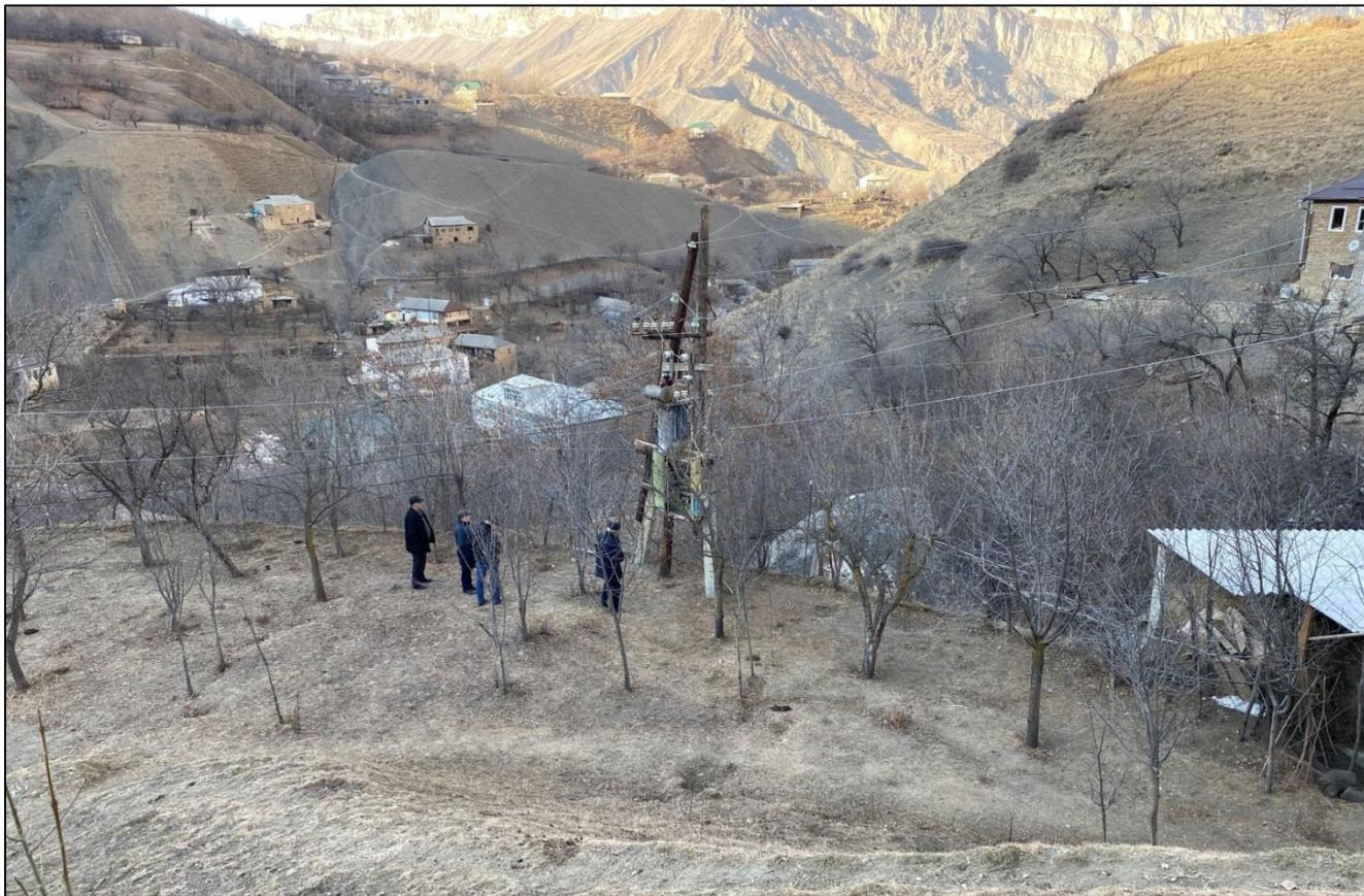
Диэлектрические перчатки пострадавшим не применялись, не выполнялась проверка отсутствия напряжения, не устанавливалось переносное заземление на провод ВЛ 0,4 кВ. ВЛ 10 кВ и шпильки выводов трансформатора.
